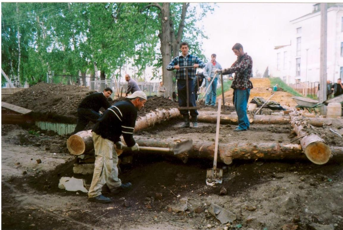
Рис. 2.9. Укладка ряжей в основание вала Богородичной Канавки у ее окончания. 2004 год<sup>170</sup>
