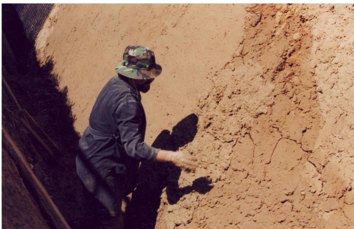
Рис. 2.12. Обмазку откоса рва выполняет паломник с Украины как при обмазке хат<sup>189</sup>
